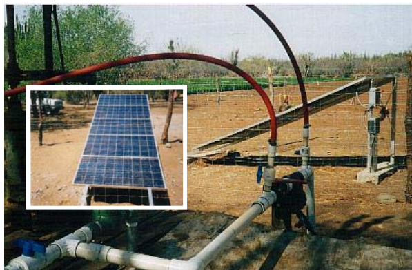
Figura 9: Sistema solar de bombeo con la parcela de riego al fondo
