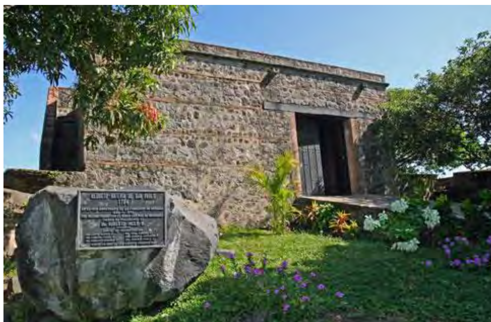
Reducto-batería de San Pablo en las Isletas de Granada. Reconstruido.
