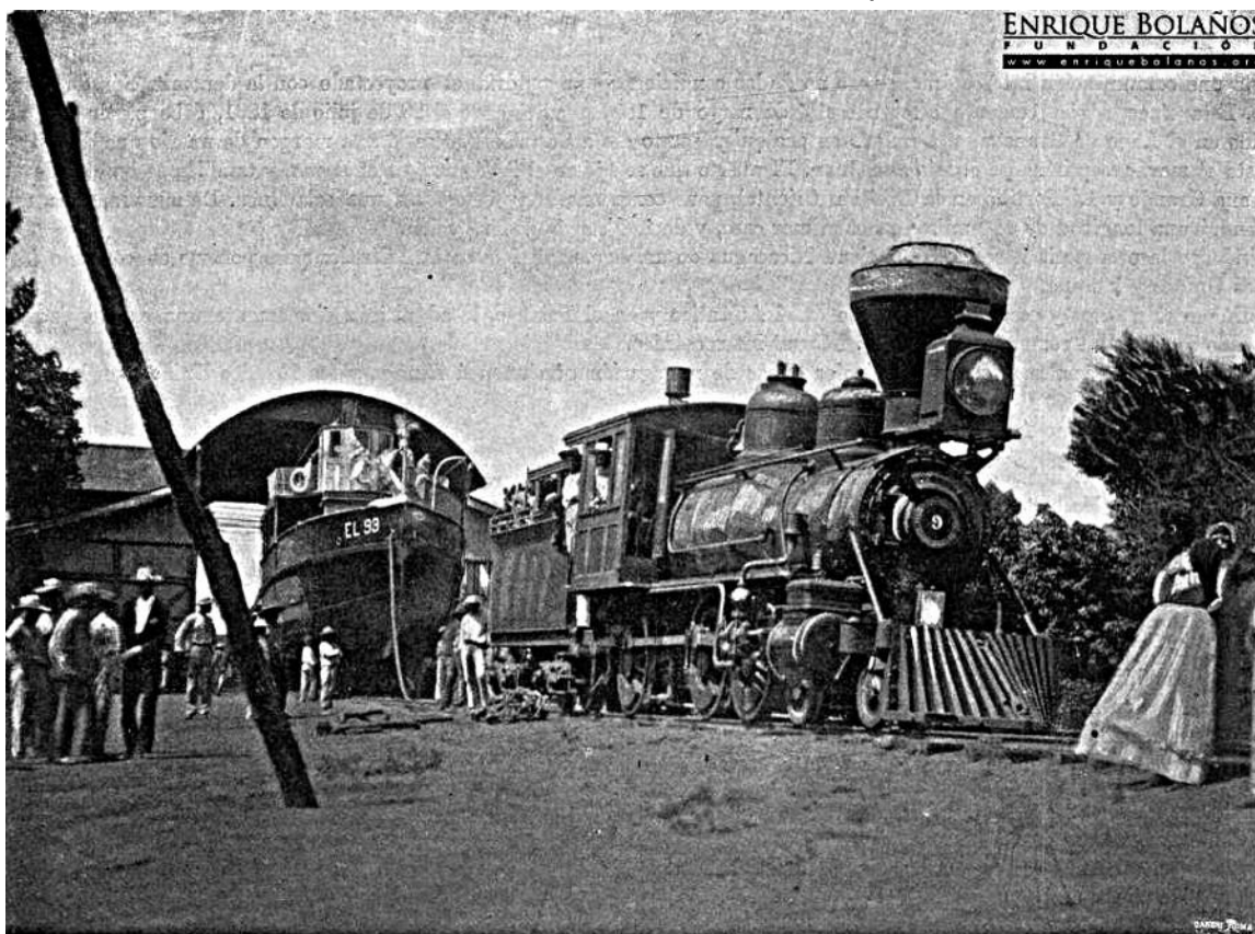
La locomotora No. 9 transportando el vapor del lago "El 93"
