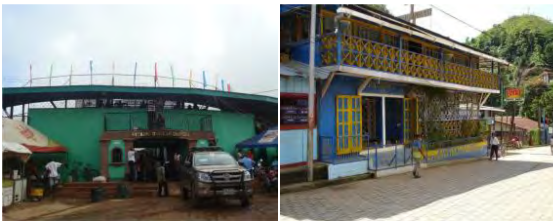
Estadio Duncan Campbell y Hotel BB2. Fuente: Panoramio, Google Earth.
