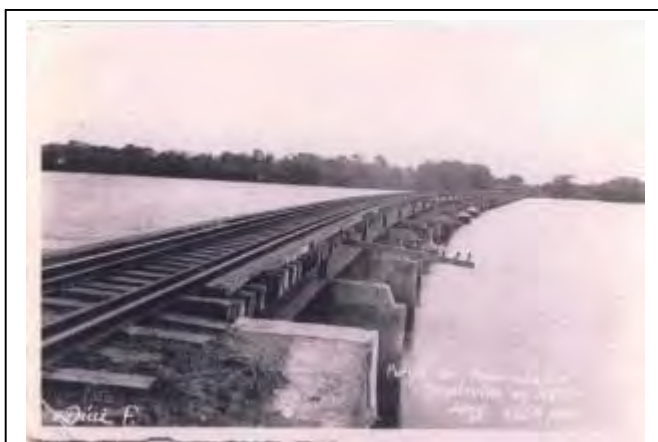
Foto 4 Puente ferroviario en Paso Caballos construido en 1880, conectaba el puerto con el resto del país, adosados a la derecha pueden observarse las líneas del telégrafo. Postal de Foto Díaz de la colección personal de la Dama Corinteña Dahlia Ramírez.
