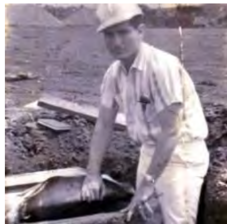
Eddy Kühl inspecciona las cajas de registro, 1968
