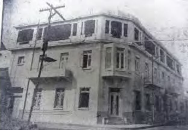
Foto 22. Casa del matrimonio Sevilla-Somoza en Managua, conocida popularmente como “Casa Lilliam”. Al ser nombrado Guillermo Sevilla Sacasa Embajador de Nicaragua en Washington y trasladarse el matrimonio a vivir en esa ciudad, se utilizó como sede del Ministerio de Relaciones Exteriores. Fue destruida en el terremoto de 1972. Foto La Noticia, 31 enero 1943.
