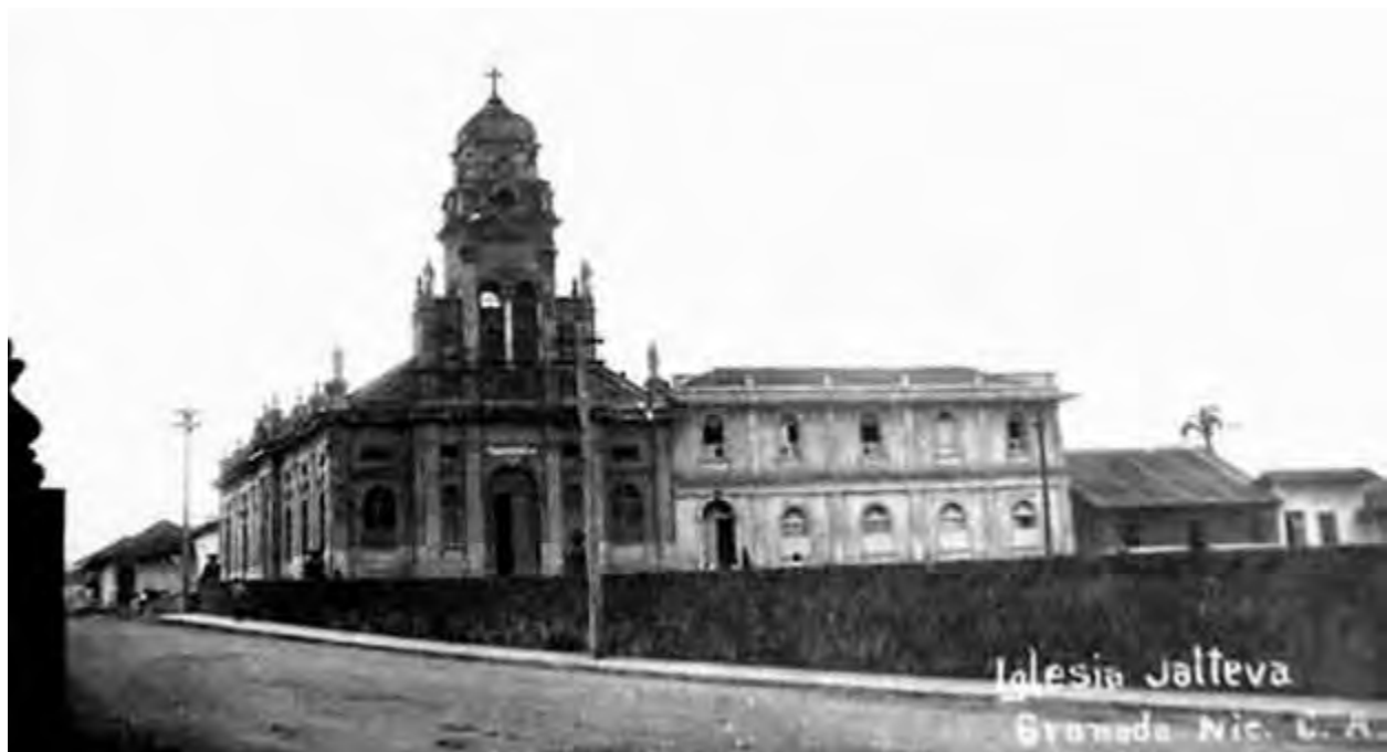
Muro norte sobre la Calle Real, e Iglesia de Jalteva
