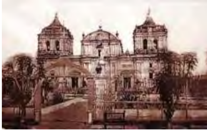
Fachada anterior a las modificaciones ordenadas por el obispo Pereira.
