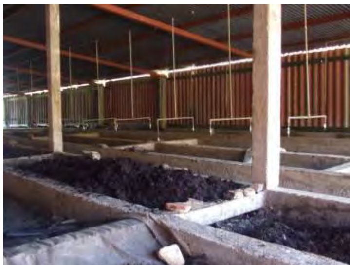
Figura 5: Apreciar el sistema de riego, paredes y techo cerrados con material reciclado, muro superior de las pilas de mampostería.
