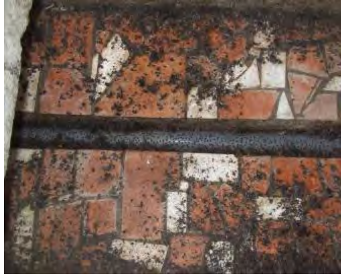
Figure 4: Fondo de la pila con ripios de cerámica a fin de que no se lastimen las lombrices, el tubo de PVC perforado es para coleccionar el lixiviado
