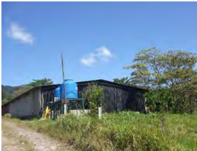
Figura 2: Culata del Palacio de las lombrices, con los tanques para lixiviado.
