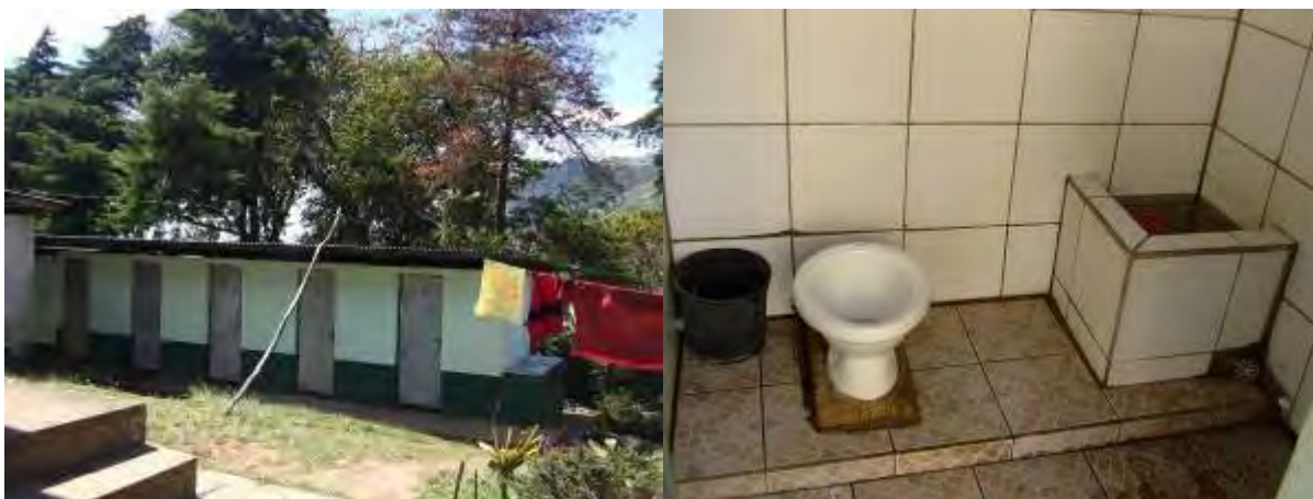
Izquierda, grupo de nuevos sistemas de servicios sanitarios; derecha, vista interior a uno de estos sanitarios
