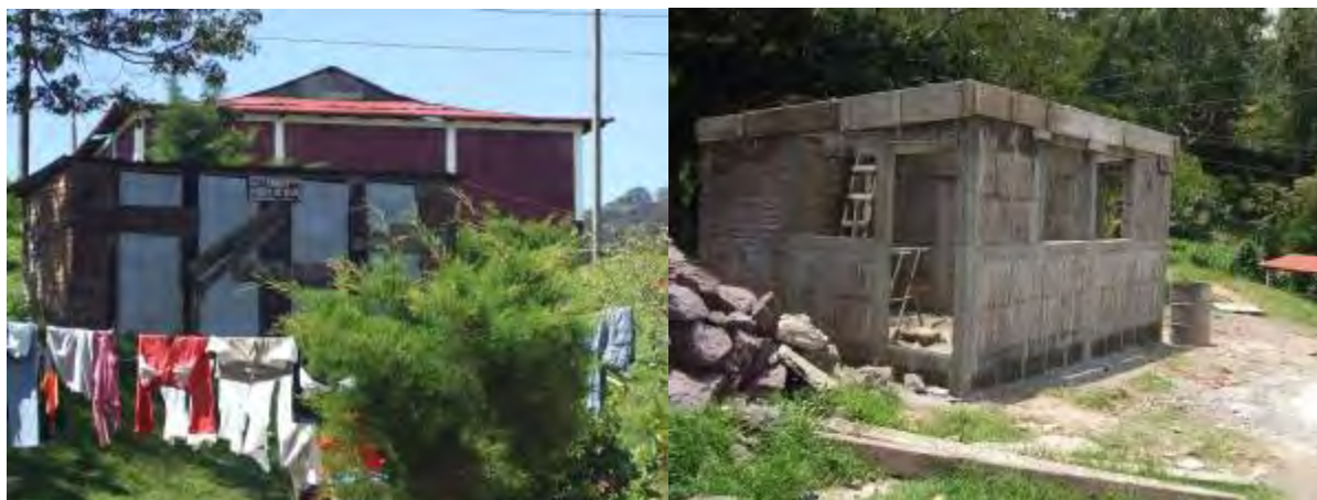
Izquierda, vista a una letrina vieja; derecha, transformación de la construcción de letrina vieja en cuarto para trabajador soltero.
