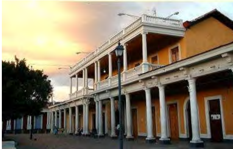
La Casa de los Leones, como luce actualmente.
