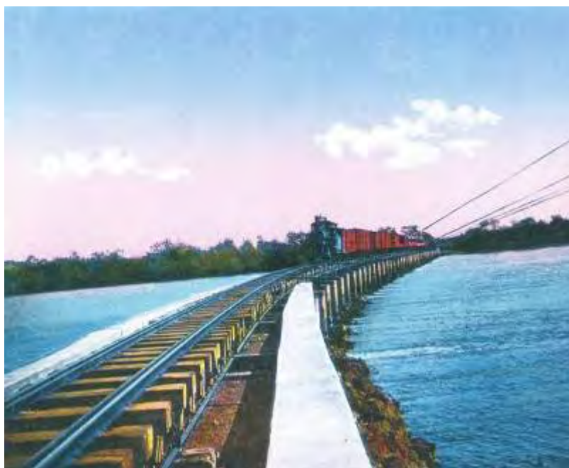
Puente ferroviario de Paso Caballos 1927, tomado de la revista “Corinto a través de sus 150 años” 2009.
