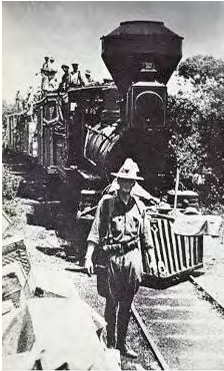
Figura 8: Marine limpiando la línea férrea, 1912
