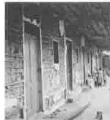
Figura 9: Casas de taquezal no sufrieron mayores daños en el terremoto de El Salvador, 1986
