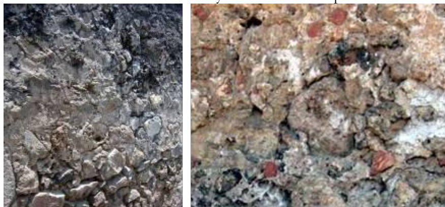
Figure 4: A la izquierda, detalle del muro de Jalteva; a la derecha, detalle del muro oeste de la Iglesia de San Francisco, ambas en Granada, Nicaragua
