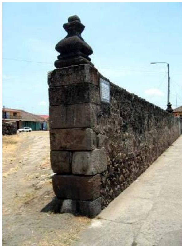
Figura 3: Muro de Jalteva, salvo la cabeza del muro—de piedra labrada sin argamasa, el resto son piedras brutas, sin labrar, pegadas con argamasa. A la izquierda se mira una rampa de piedra para controlar la erosión del drenaje pluvial de la plaza de Jalteva. La piedra labrada superior tiene grabadas la fecha y el nombre del constructor. Foto del autor.
