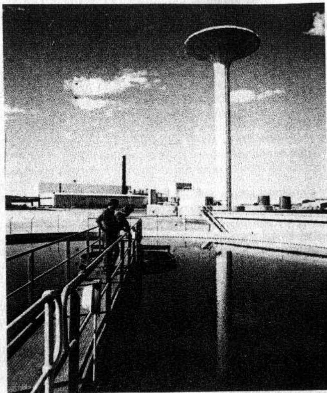
Fig. 4.1 El suministro de agua es esencial para las fábricas de cerveza; algunas almacenan grandes volúmenes como muestra la torre de agua de esta fotografía, tomada en la Swan Brewery de Perth, Australia Occidental. El tratamiento de efluentes es otra de sus preocupaciones importantes y se muestra también en el frente de la fotografía.
