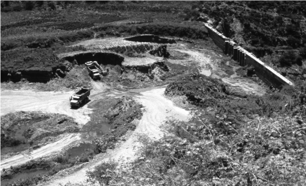
Foto 5: Dique relleno con sedimentos en Eritrea: ¿Se podría haber alargado la vida útil del dique con medidas de conservación de suelos río arriba?
