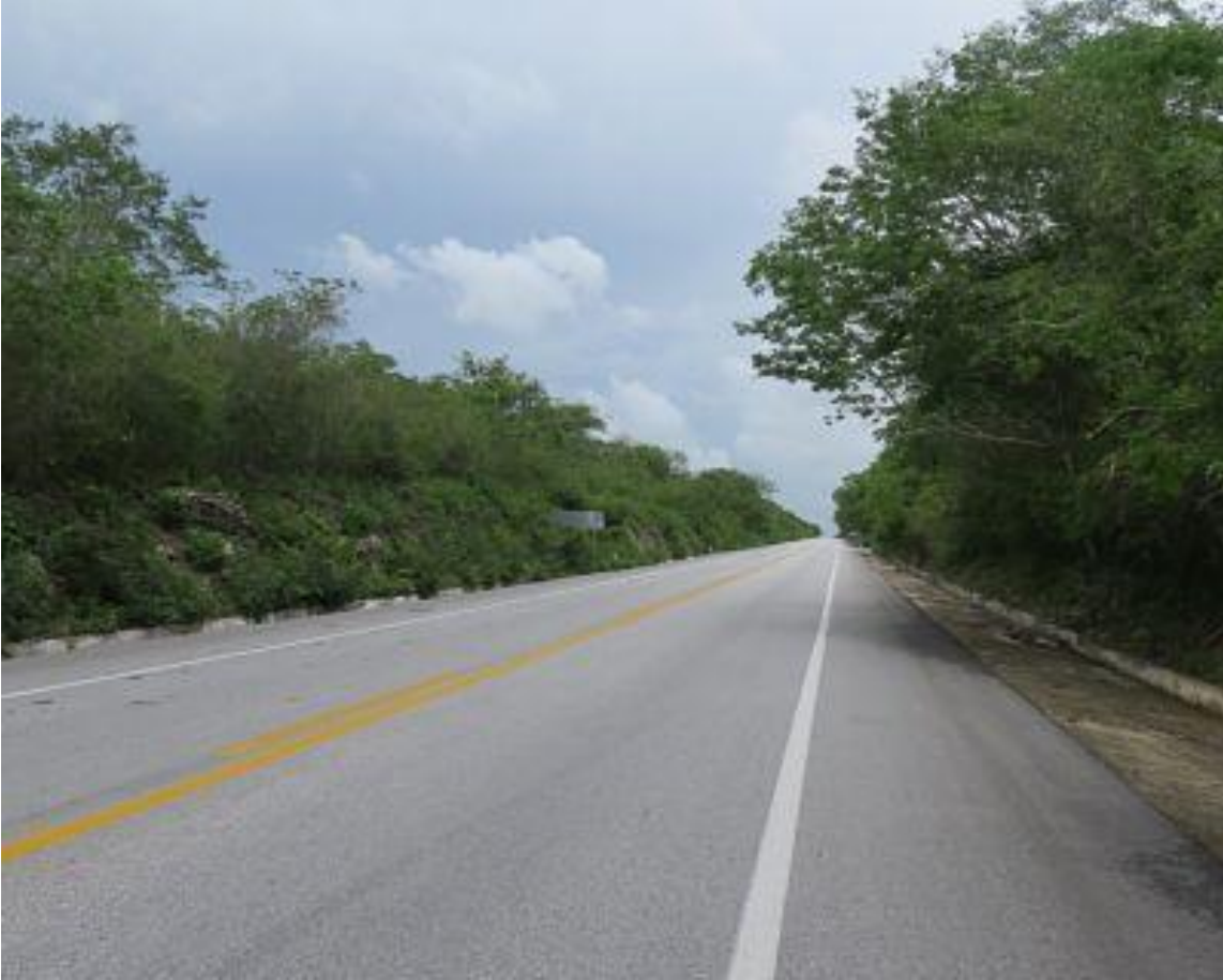
Figura 2. Tramo de la carretera federal 186.
