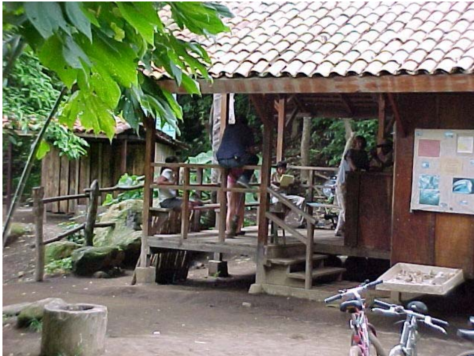
Casa de los guarda parques.
