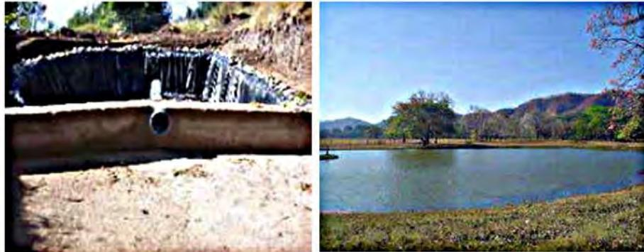
Fotografías 3 y 4. Laguneta con revestimiento de geo-membrana (izq.)
