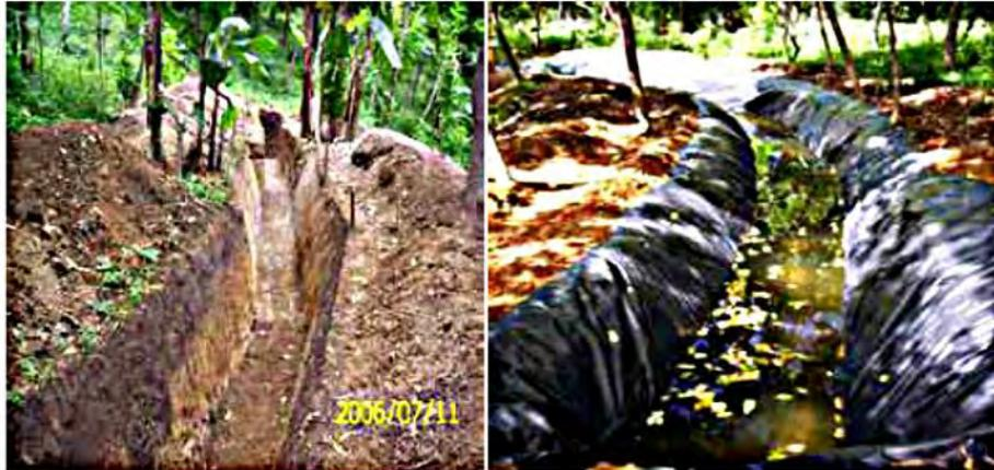
Fotografías 6 y 7. Excavación de zanja de almacenamiento (izq) y zanja revestida (der).
