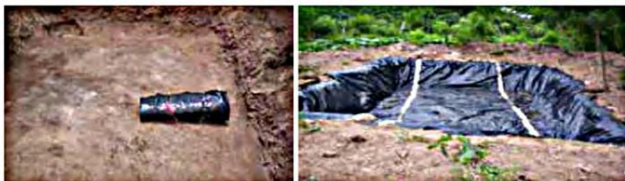
Fotografías 9 y 10. Excavación y base del aljibe (izq) y aljibe revestido con polietileno (der). Fuente: Cajina (6)
