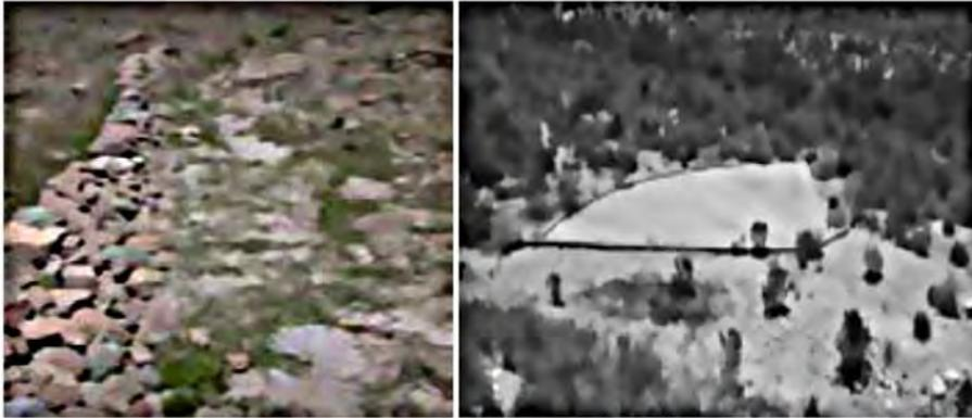
**Fotografías 14 y 15. Camellones de piedra (der) para retención de aguas. Ladera acondicionada en forma de abanico y con revestimiento de concreto para captación de agua de lluvia, puede revestirse con polietileno.**
