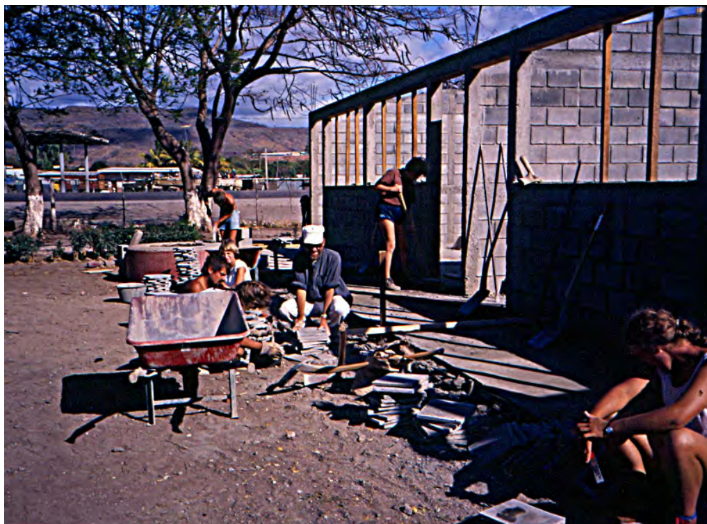
La obra gris casi terminada de una de las aulas de Sébaco.
