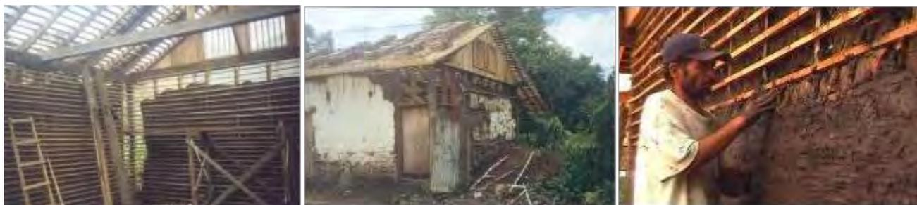
Para el tejado se utilizaron las tejas originales, hasta donde estaban utilizables. El resto se completó con tejas compradas de construcciones antiguas del vecindario que han sido “modernizadas” con techados de zinc corrugado. El piso de ladrillos de barro cocido tuvo que ser reconstruido, ya que se encontraba en muy mal estado. Sin embargo, para ello se utilizó exactamente el mismo tipo de piso: ladrillos de barro cocido.
