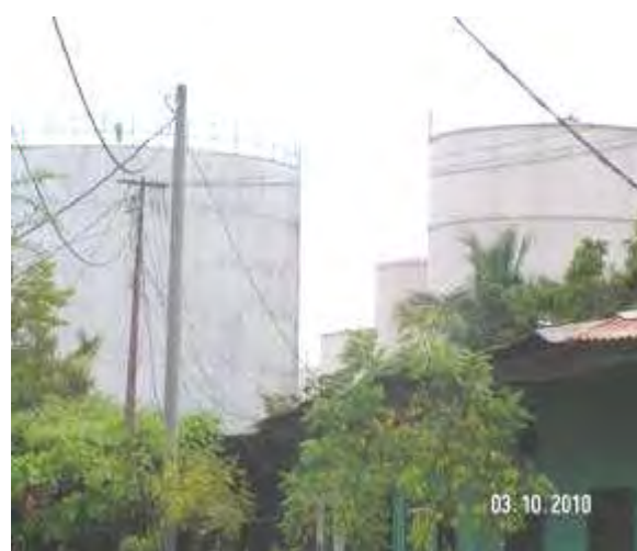
Foto 9 Viviendas colindantes con los muros de los tanques de combustible.
