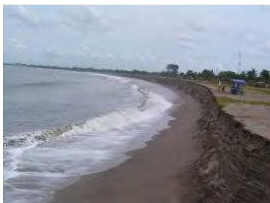
Foto 1 Vista actual de la playa de Corinto frente a mar abierto, sobre la cual se instalaron baterías artilleras de defensa del US Army Para la Base Naval. Octubre 2010.
