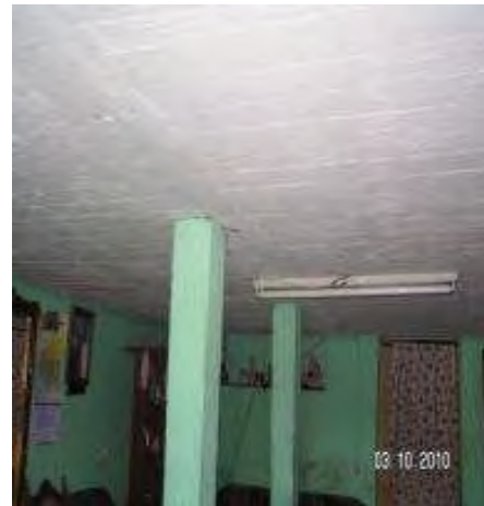
Foto 4. Casa conocida actualmente como “casa de piedra” en el barrio de la Base Naval, originalmente un almacén. Obsérvese techo y paredes de concreto.
