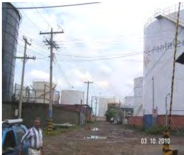
Foto 8 Vista parcial de calle de entrada a los “tancones”, en este sitio estaba uno de los portones de acceso a la Base Naval.
