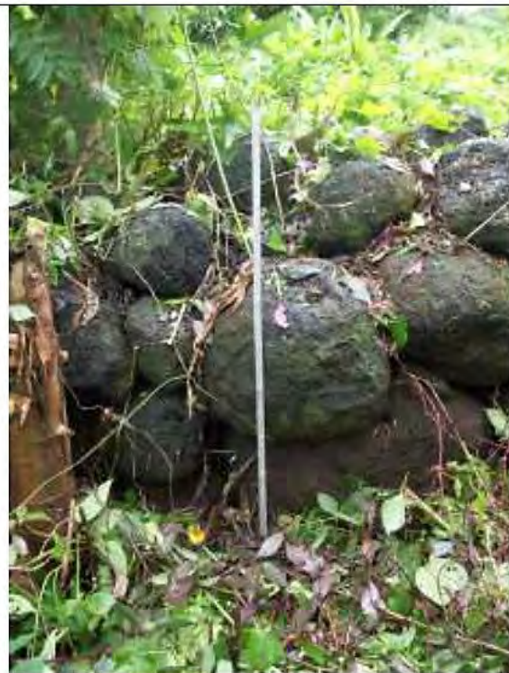
Fig. N° 8. Detalle del “muro de los esclavos”, Corn Island. (foto R. Navarro 2011)
