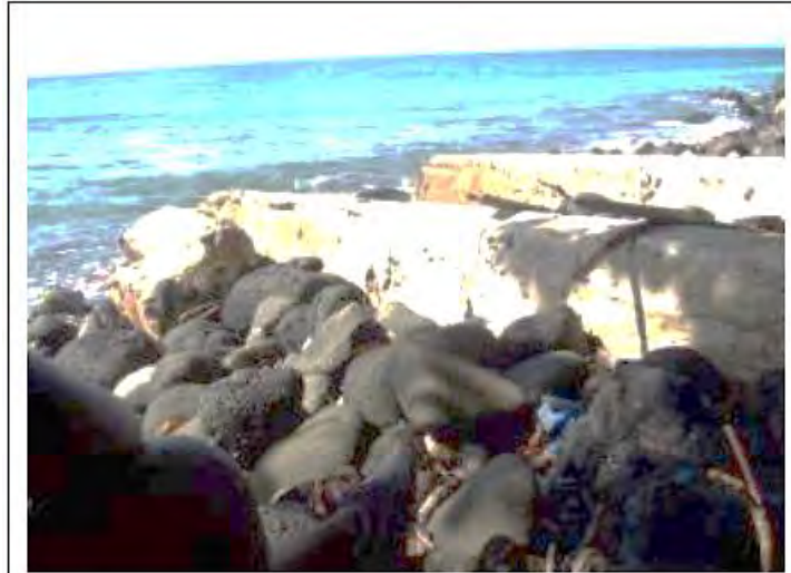
Fig. N° 18. Gradass del antiguo astillero aparentemente construido alrededor de 1970
