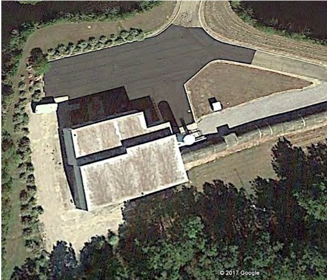
Extremo de uno de los brazos del interferómetro. Dentro de este edificio está el espejo que envía el haz de luz de regreso al edificio principal donde está el fotodetector.
