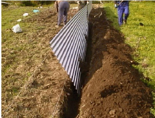
*Foto 5: Forma de montar las placas del perímetro*
