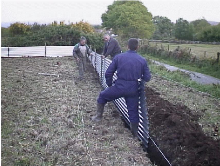
*Foto 7: Colocando las planchas galvanizadas*
