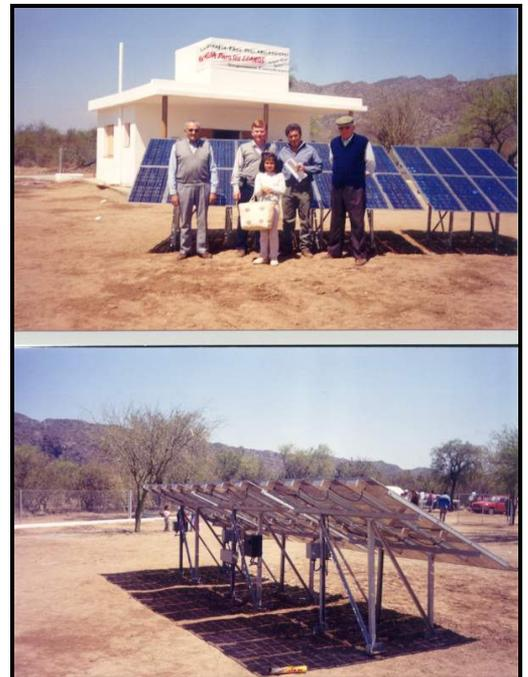
**Fig. 5.** Estructura Soporte de Panel Fotovoltaico de 24 Módulos [3]
