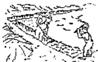
5. Construcción del drenaje periférico
