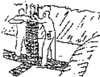
8. Preparación de ventanillas de gases
