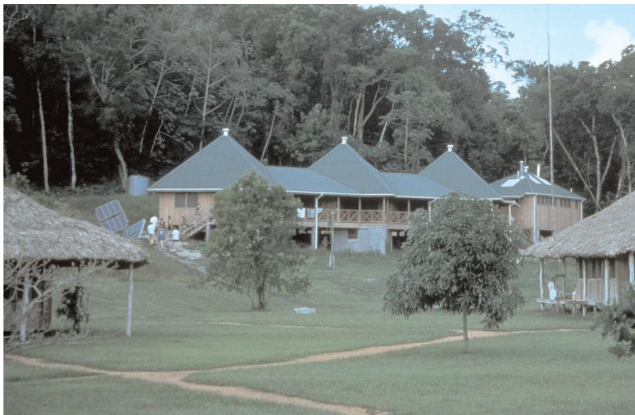
Cabanas para hóspedes em La Milpa, Área de Conservação do Rio Bravo, Belize © Andy Drumm
