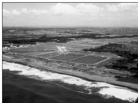
Granja camaronera inmediatamente detrás de la playa y de bajas dunas cubiertas de vegetación. Costa Pacífica de Guatemala, noviembre de 1995. (Fotografía: Martín Bilio)
