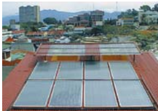
Fig. 10. Sistema solar para hotel
