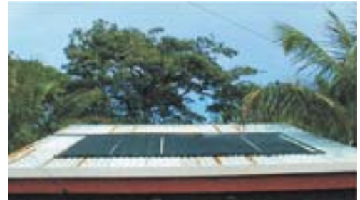
Figura 3. Colectores solares para calentamiento de piscinas.
