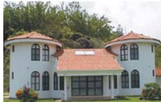
Fig 8. Sistema solar tipo forzado instalado en Costa Rica
