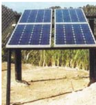
Figura 4. Conjunto de paneles fotovoltaicos típico y su estructura metálica de soporte.
