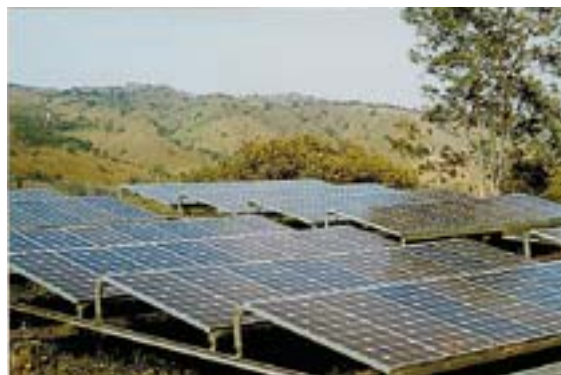
Figura 8. Sistema fotovoltaico de Capurí, Panamá.
