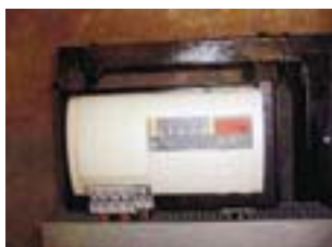
Figura 6. Típico regulador de carga fotovoltaico con sus respectivos bornes de conexión para el módulo, para la batería y para las cargas.
