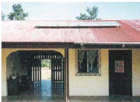
Sistema fotovoltaico instalado en una clínica de salud en la Zona Norte de Nicaragua
