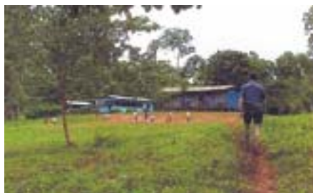
Figura 11. Escuela pública con iluminación solar en la Península de Osa - Costa Rica.
